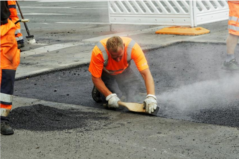
Abbildung 13: Die Anschlussstücke wurden in Gussasphaltbauweise ausgeschrieben
