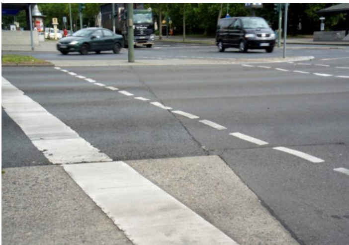
Abbildung 2: Kreuzungsbereich der B 96 vor der Sanierung
