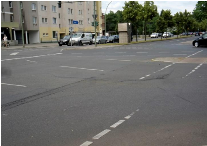
Abbildung 3: Kreuzungsbereich der B 96 vor der Sanierung
