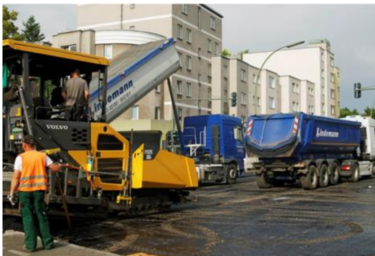
Abbildung 11: Einbau Binderschicht
