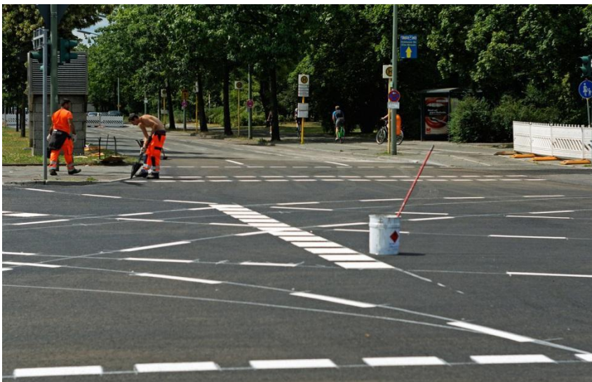
Abbildung 17: Am 06.07. wurden Fugen geschnitten (unterschiedliche Asphalte) und vergossen und alle vorläufigen Markierungsarbeiten erledigt. Die Verkehrsfreigabe erfolgte planmäßig am 07.07.2014
