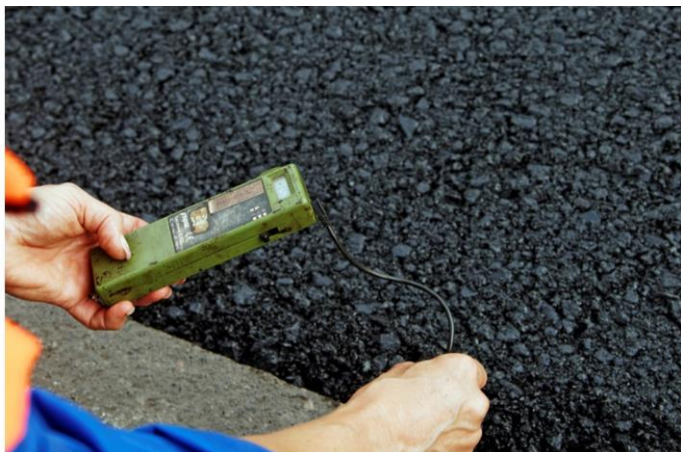
Abbildung 9: Temperaturmessung der verlegten Binderschicht – 168°C
