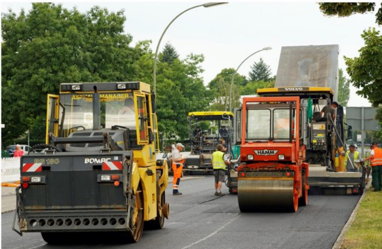
Abbildung 14: Verdichtung
