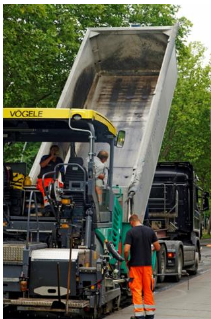
Abbildung 12: Einbau der Binderschicht. Keine Anhaftungen von Mischgut auf der Pritsche
