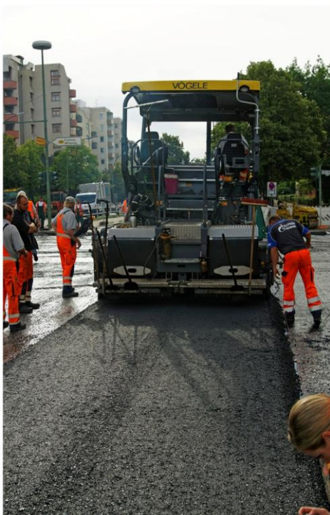
Abbildung 8: Der Einbau der Asphaltbinderschicht
