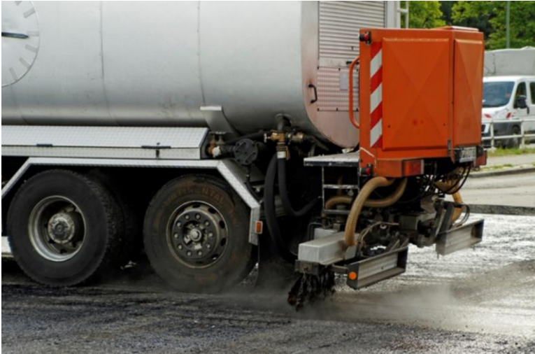
Abbildung 5: Bitumenemulsion C60BP1-S mit einer Menge von 350 g/m 2 wurde für Deck- und Binderschicht verwendet
