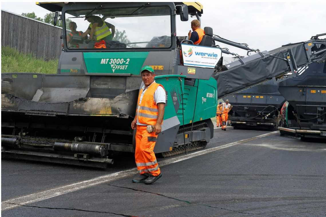
Bild 7 und 8: Voller Maschineneinsatz: Vier gestaffelte Fertiger, die von zwei Beschickern versorgt wurden, Walzen ohne Ende (10 Walzen im Dauereinsatz, 3 weitere Verdichtungseinheit als Standby) und rund 85 LKW im Umlauf.
