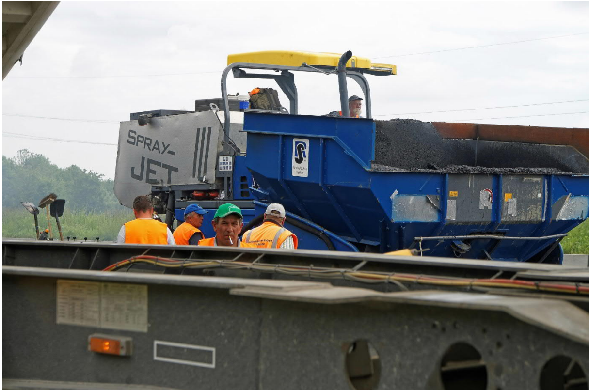
Bild 9: Sprühfertiger sorgen für den richtigen Halt auf dem Asphaltbinder
