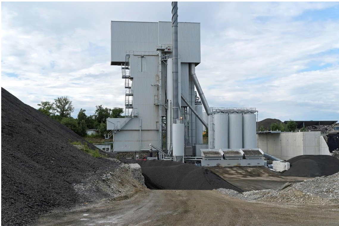
Bild 2: Asphaltmischanlage in Gilching
