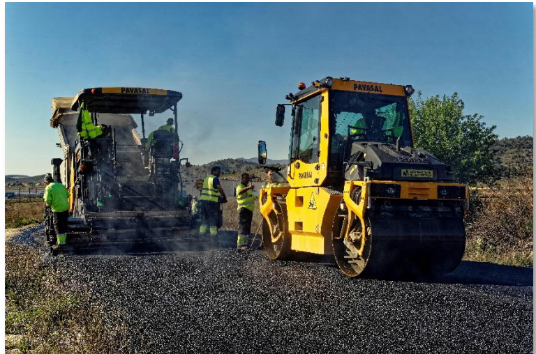
Bild 3: Verdichtungsarbeit mit einer Bomag Glattmantelwalze
