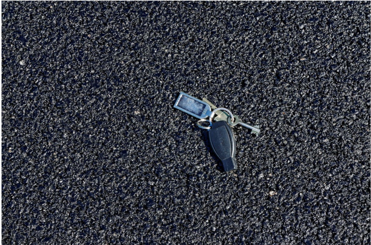
Bild 10: Textur Splittmastixasphalt
