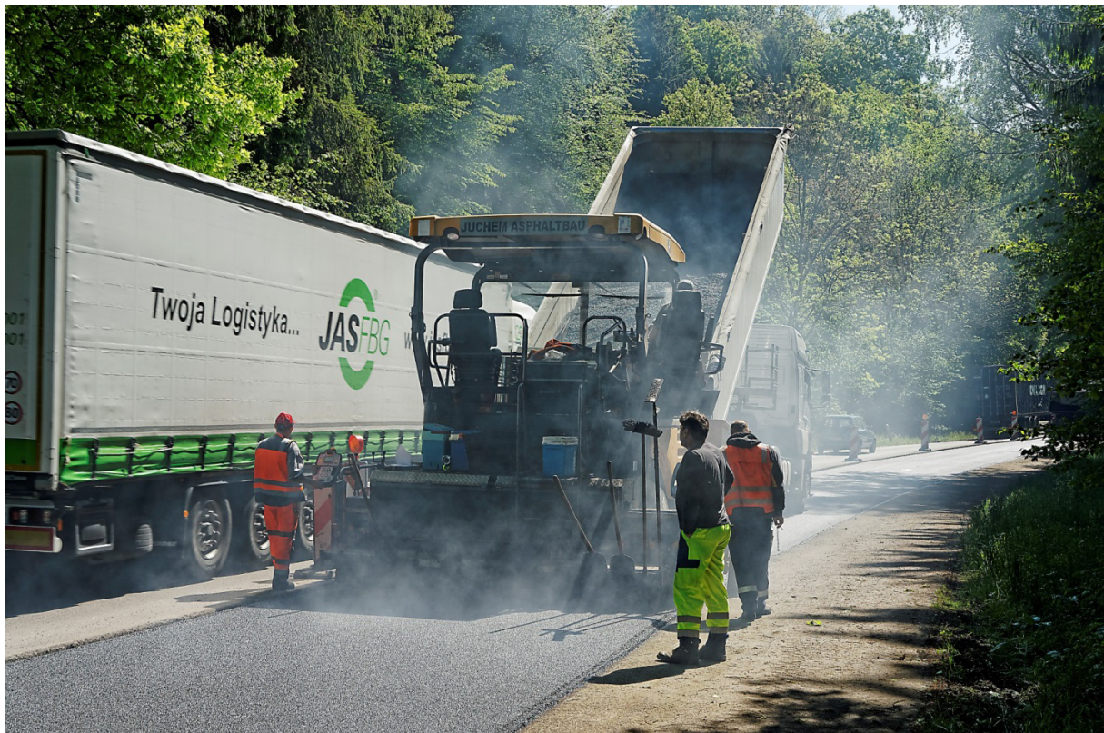
Bild 9: Einbau unter Verkehr
