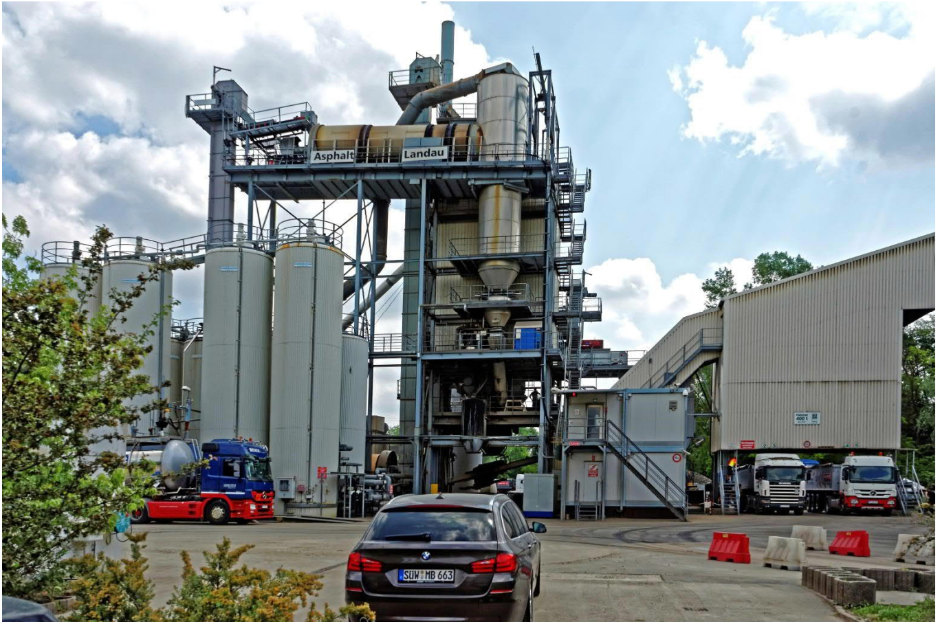
Bild 1: Asphaltmischanlage Landau der Juchem-Gruppe
