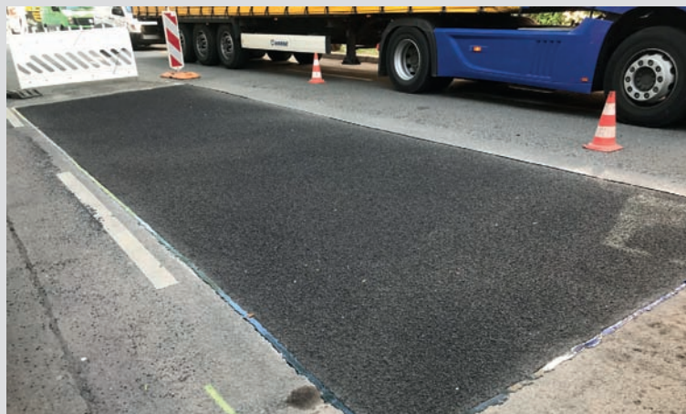
Bild 2: Fertiggestellte großflächige Flickung
