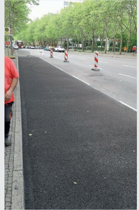
Bild 5: Fertiggestellte Asphaltfläche im Bushaldebereich
