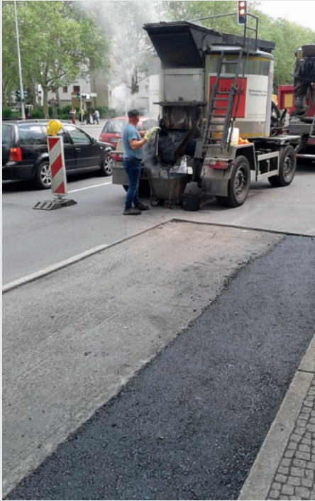
Bilder 3 und 4: Gussasphaltverlegung
