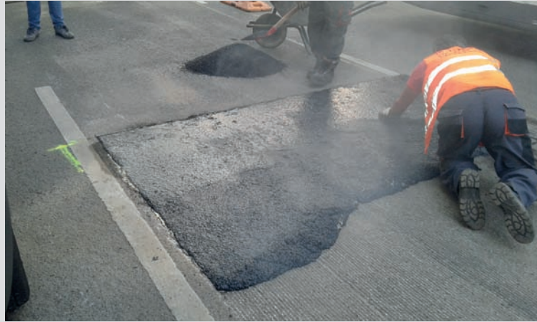
Bild 1: Gussasphalt- verlegung
